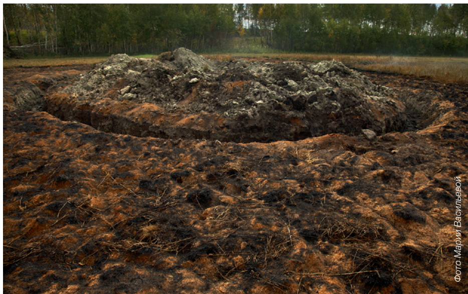
Рис. 36. Локализация небольшого очага траншеей. Неправильно: отвал — со стороны очага. Перебросы искр через канаву привели к появлению новых очагов тления по всему периметру. Бурятия
