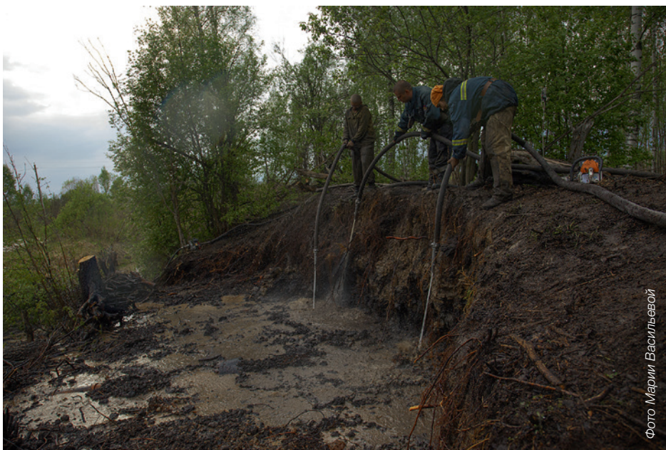
Рис. 18. Тушение очага на отвале осушительного канала. Завершающая стадия тушения. Ивановская область
