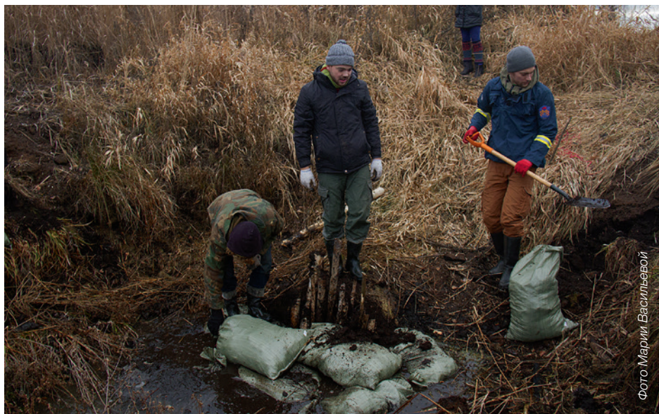
Рис. 28. Создание временной земляной плотины на трубопереезде (обводнение, создание места для забора воды пожарной техникой). Тверская область
