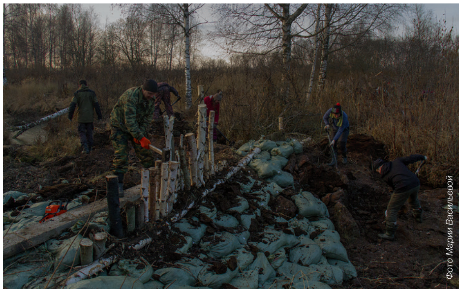
Рис. 30. Создание временной переливной торфяной плотины на магистральном канале вручную. Мешки с торфом, брёвна. Перелив выполнен в виде канавки в торфе (на заднем плане) и отводит избыток воды на выработанные торфяные карты, с которых вода возвращается в канал ниже плотины. Тверская область
